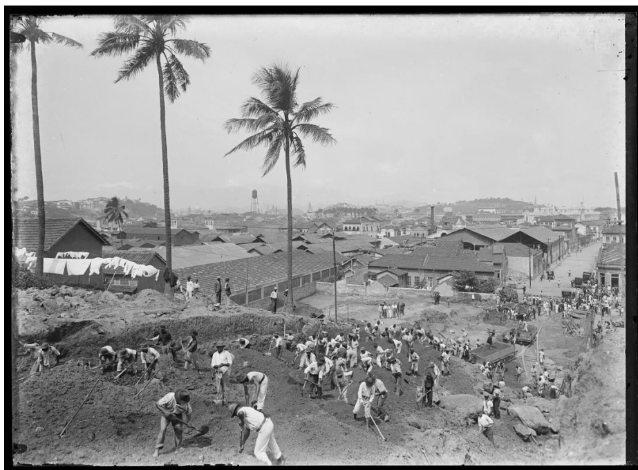
Figura 47: Abertura do túnel João Ricardo, 1920. Fonte: Instituto Moreira Salles.
